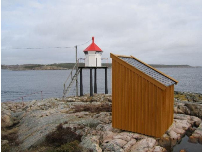
Gitmertangen øvre og nedre fyrlykter, begge med oljeboder og Merdø fyrlykt ble alle fredet i 2016. Bildet viser Gitmertangen nedre fyrlykt med oljebod. Foto Arendal kommune.
